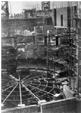
Стальной каркас зала во время монтажа, фотография Delmaet и Durandelle, (Париж, БМО), снято 10 мая 1865 года. Фермы пола в зале следуют форме будущих сводов потолка в ротонде владельцев абонементов. Монтаж металлических конструкций стен, а стальные фермы полов в ложах двух нижних ярусов уже установлены.
